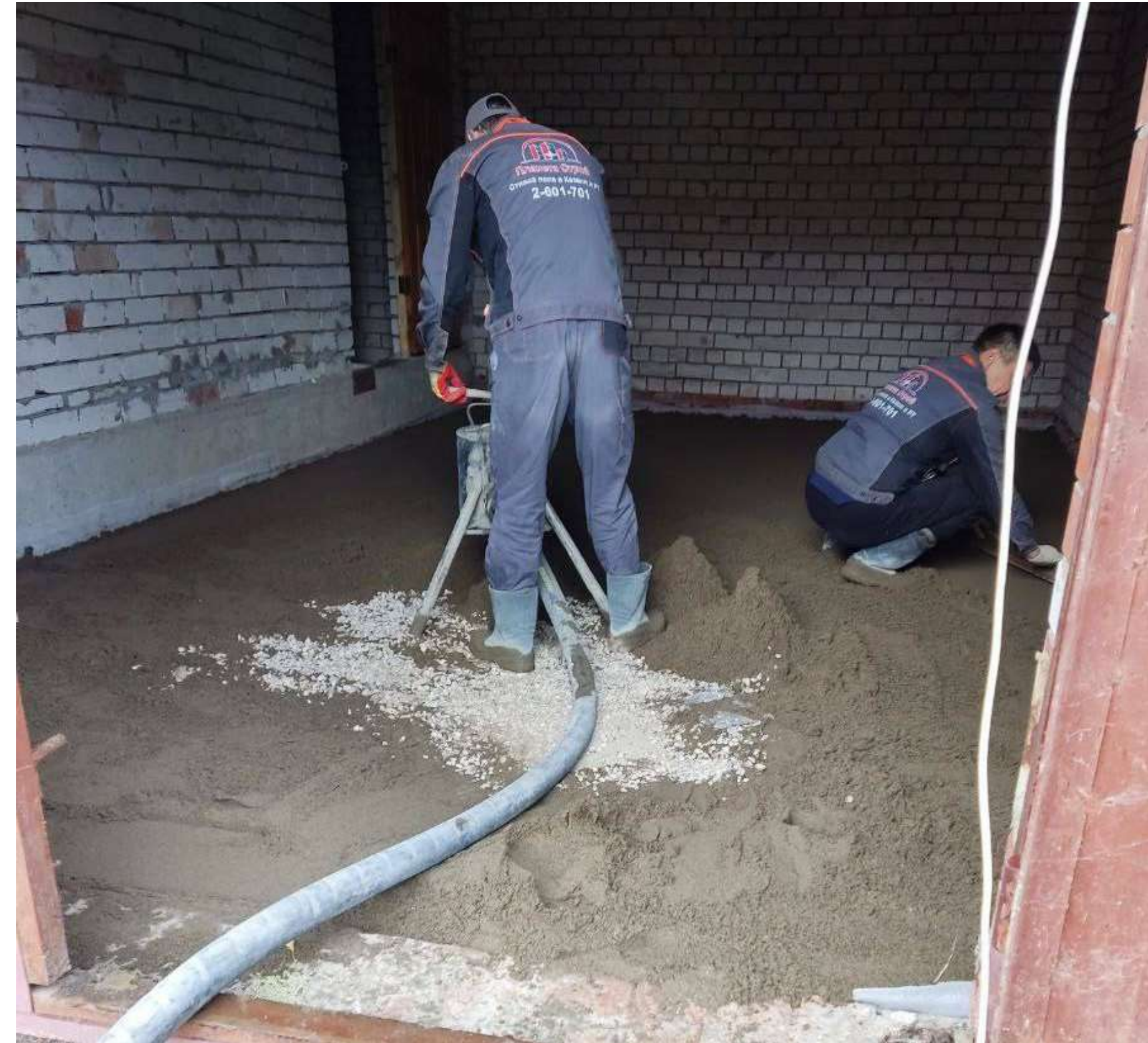
Ремонт помещения в детском доме
